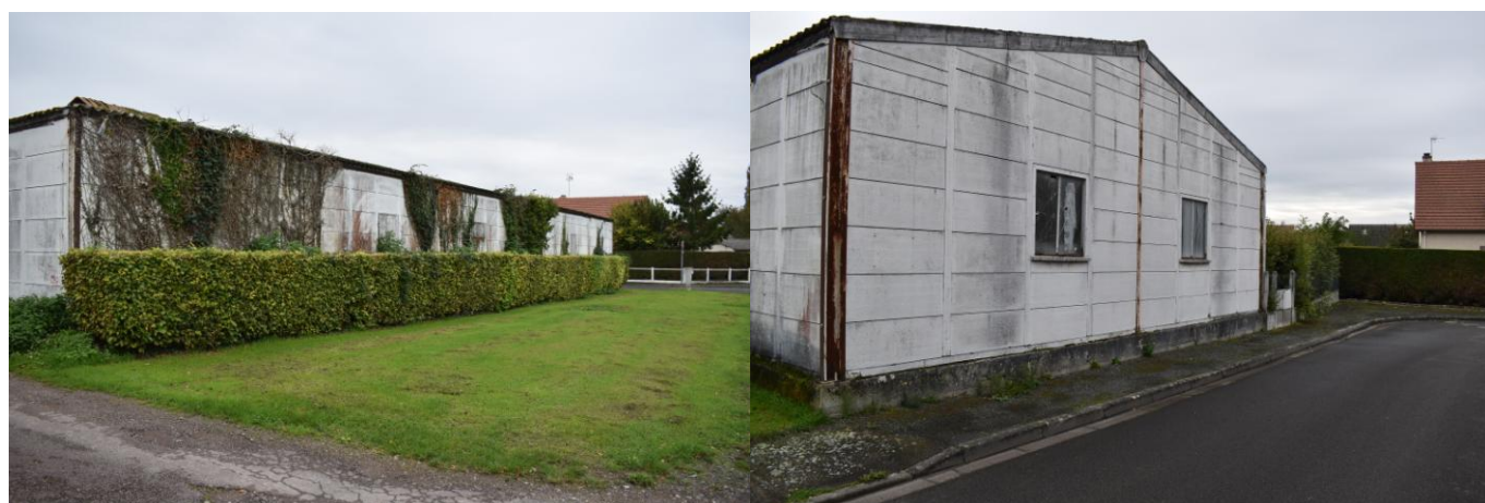
Ancien hangar de stockage... vue depuis la rue de l'Ancienne Mairie et de la rue de la Bergerie
