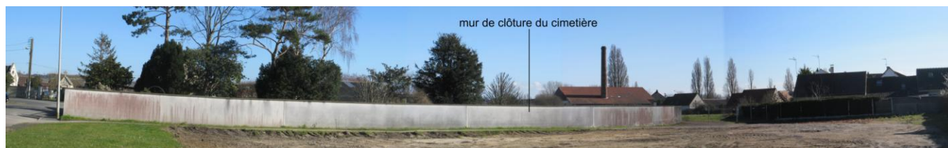
Vue sur le mur de clôture du cimetière existant
